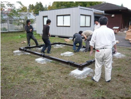
Fig.5 基礎を鋼材に改良
