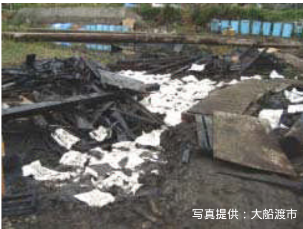
Fig.4 「杉の油取り」による回収 (H23.9.19 大船渡市)
