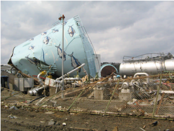
Fig.1 燃料タンク倒壊の様子 (H23.4.21 気仙沼市)
