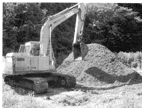
Fig. 4 パイルの攪拌の様子
