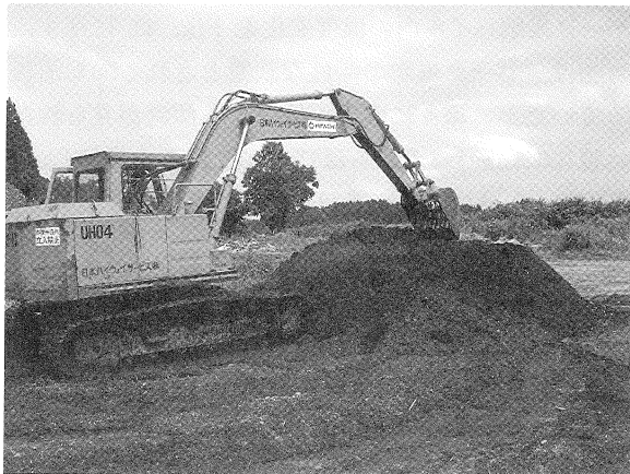
Fig. 5 パイルの攪拌の様子
