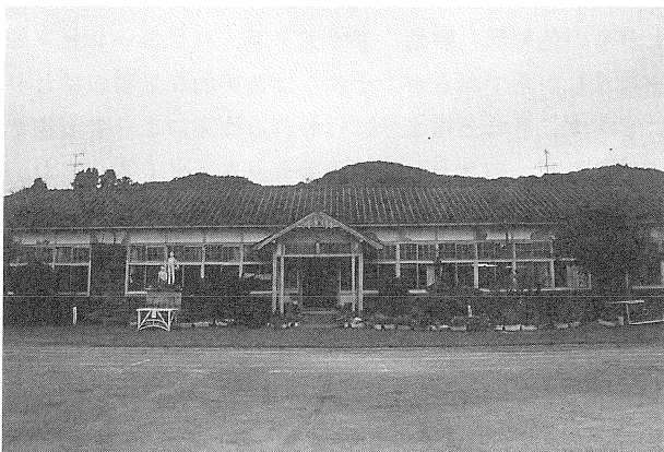
Fig.1 築後約90年の国見町岐部小学校
