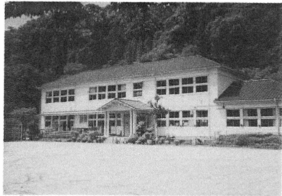
図(Fig.5) 屋形小学校(本耶馬溪町)
