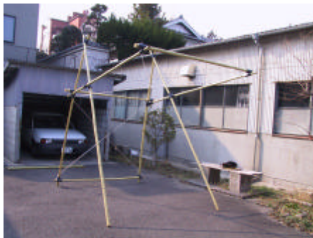
Fig.3 組み上がった構造部分
