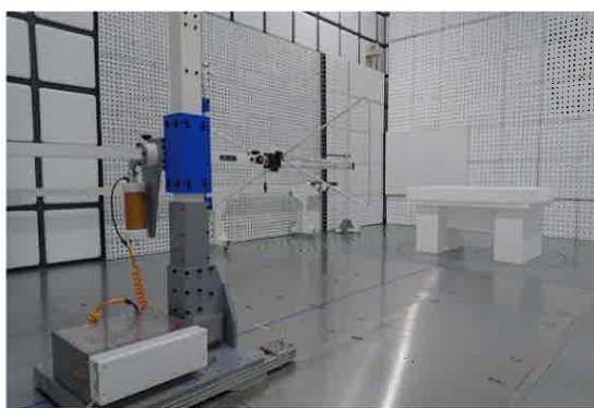
（株）リケン環境システム製 電波暗室
